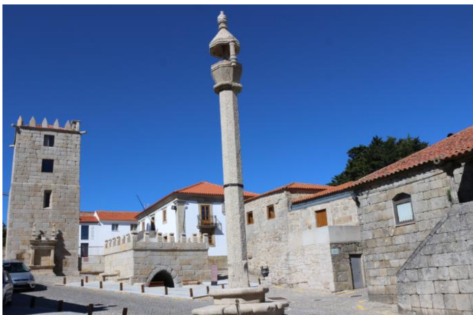
Figura 3 - Torre Ameada (Relógio), Fonte Ameada e Pelourinho de Aguiar da Beira
